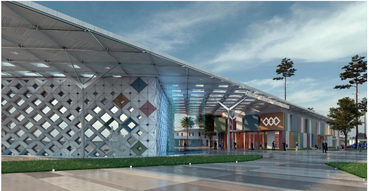
المدخل الرئيسي لمدينة المهن والكفاءات لجهة فاس-مكناس
