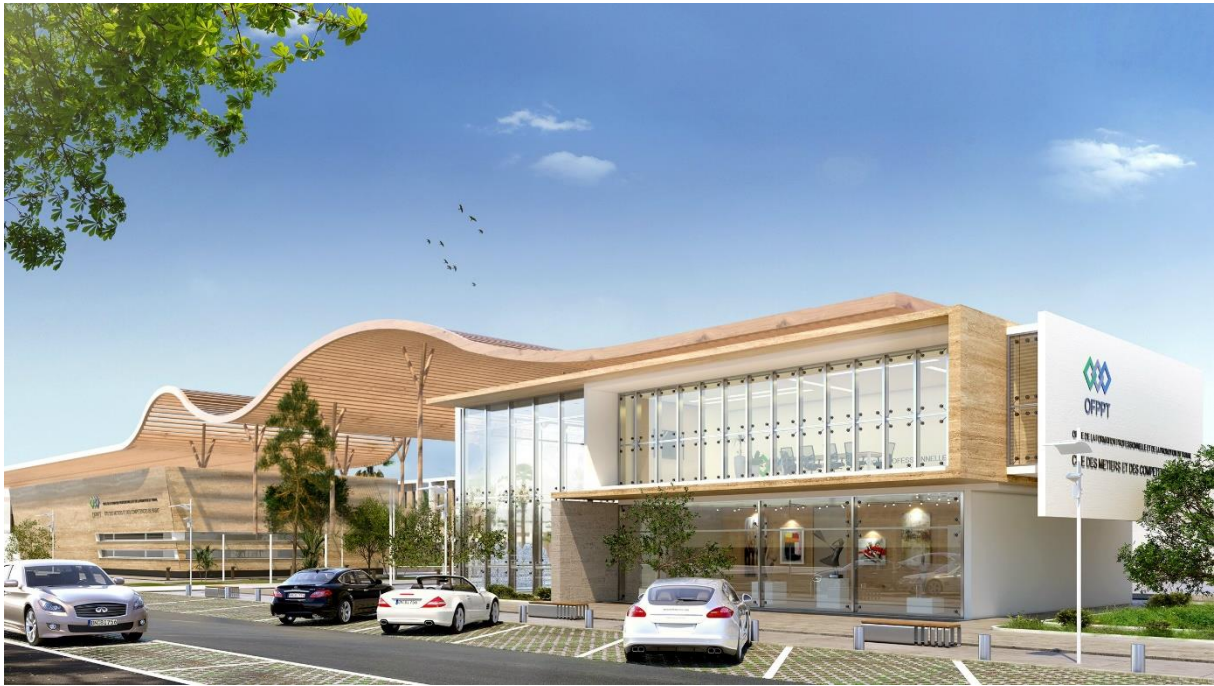
المدخل الرئيسي لمدينة المهن والكفاءات لجهة الرباط-سلا-القنيطرة
