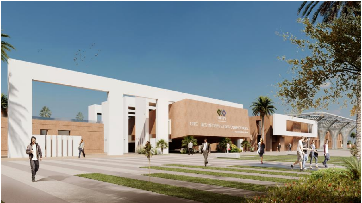
Vue sur l'entrée principale de la Cité des Métiers et des Compétences de Béni Mellal-Khénifra
